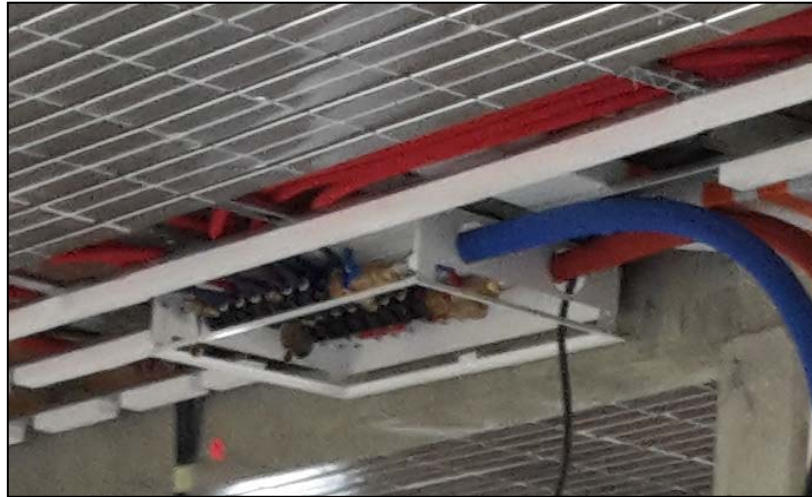
Figure C – Exemple de collecteur monté
