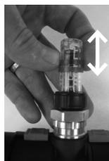
**2.** Placer la fenêtre de l'anneau indicateur sur l'échelle de graduation du débit mentionné dans l'étude hydraulique
