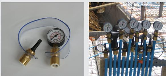
Dans le cas où le remplissage à l'eau n'est pas envisageable, un kit de mise en épreuve permet de tester individuellement et simultanément chaque boucle sous une pression d'air de 6 bars dès la pose du tube effectuée et durant la phase de bétonnage. Il est retiré le lendemain du bétonnage.
